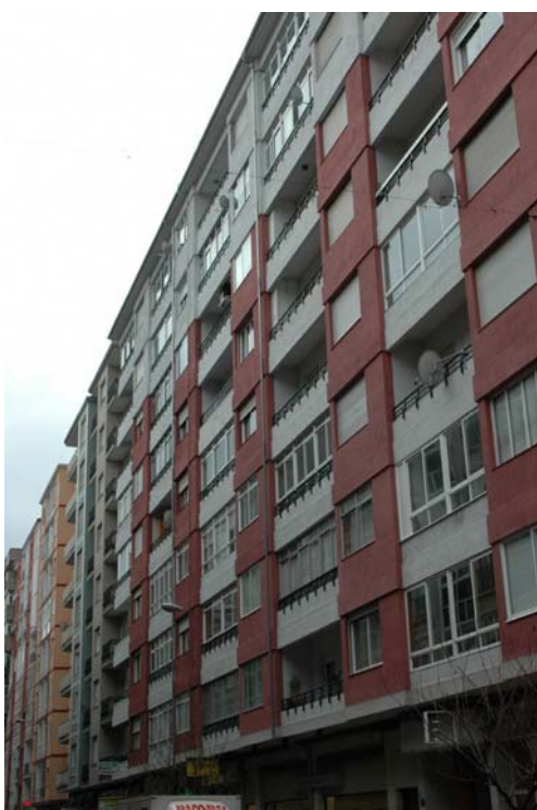
Imagen 4. Edificio en Rúa Fleming: las persianas originalmente exteriores en algunas viviendas han pasado a ser interiores
