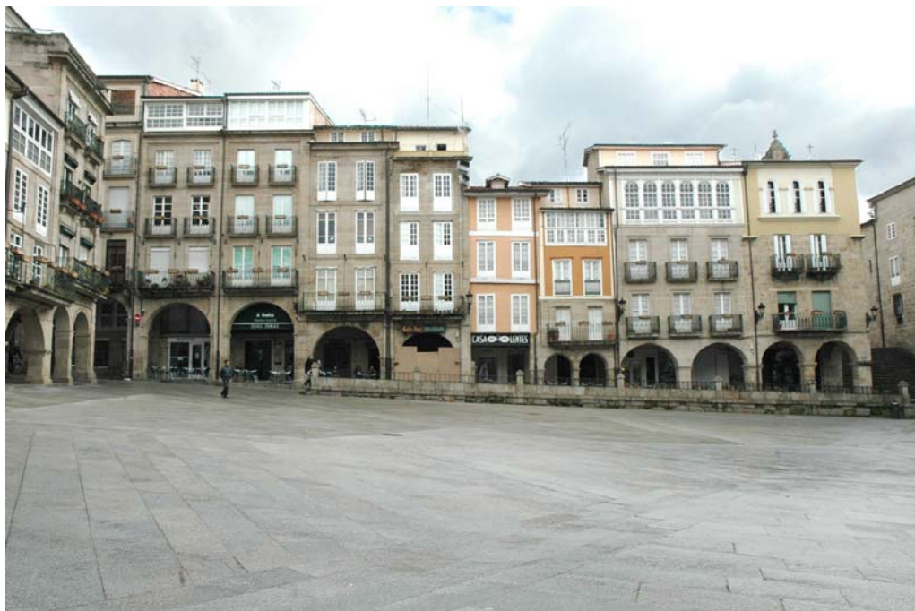
Imagen 7. Edificios de viviendas en la Plaza Mayor
