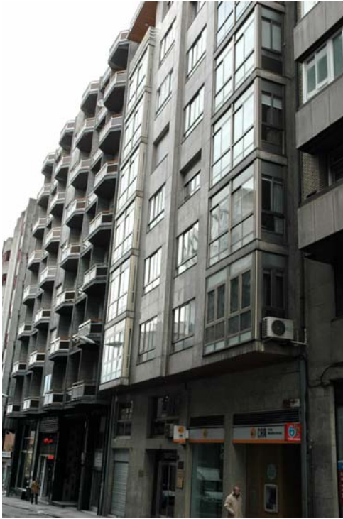
Imagen 2. Edificios de viviendas en la Calle Progreso: bajo y ocho plantas
