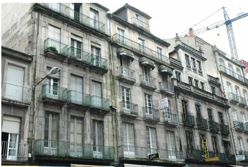
Imagen 10. Edificios de viviendas en la calle Progreso
