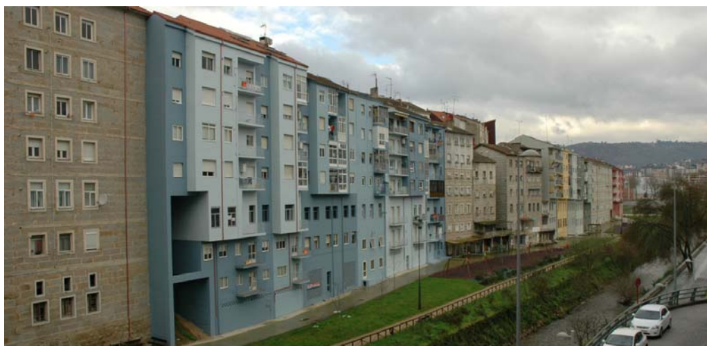
Imagen 9. Edificios en la margen izquierda del río Barmaña
