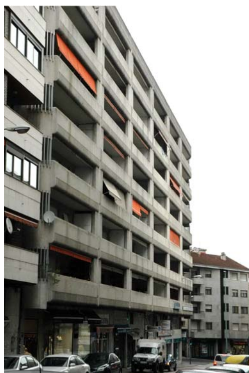
Imagen 5. Edificio en Avenida de Portugal: balcones profundos en algunos casos protegidos con toldos
