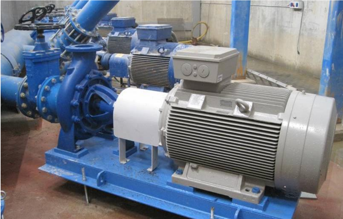
Ilustración 12. Installed reversible pump.
