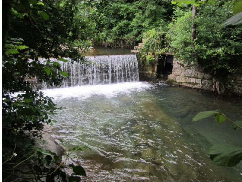
Foto 2. Arroyo Artesiaga, presa del Molino de Aiarroz. Actualmente en desuso y difícilmente franqueable por las especies piscícolas.
