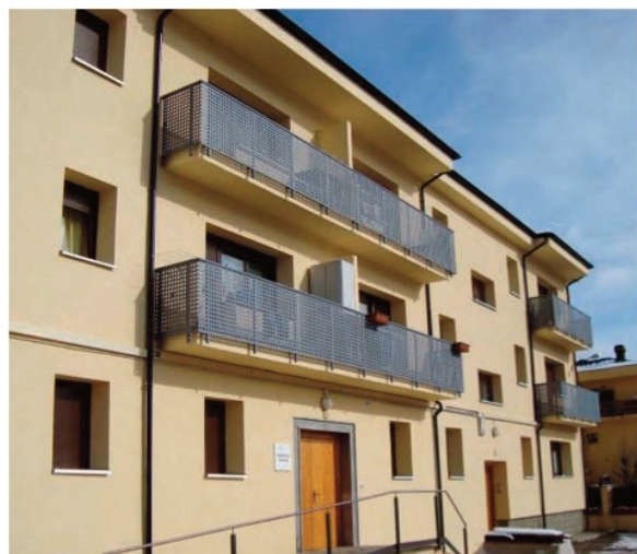
Figura 2 - Imagen del edificio tras las actuaciones de rehabilitación
