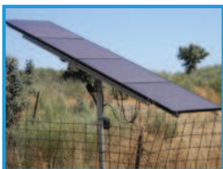
Fig. 9 y 10: Imagen del pozo y al fondo los módulos solares. Detalle de los módulos con el seguidor.
