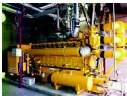
El tipo de combustible empleado en los motores puede ser gas natural, propano, biogas o gasóleo. La opción más viable es cogenerar con un motor alternativo, a gas natural, y aprovechar los gases de escape en una caldera de recuperación para generar vapor a presión.
